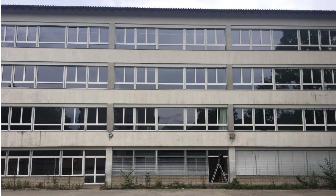
Ecole de la Vignettaz, bâtiment B, Fribourg
